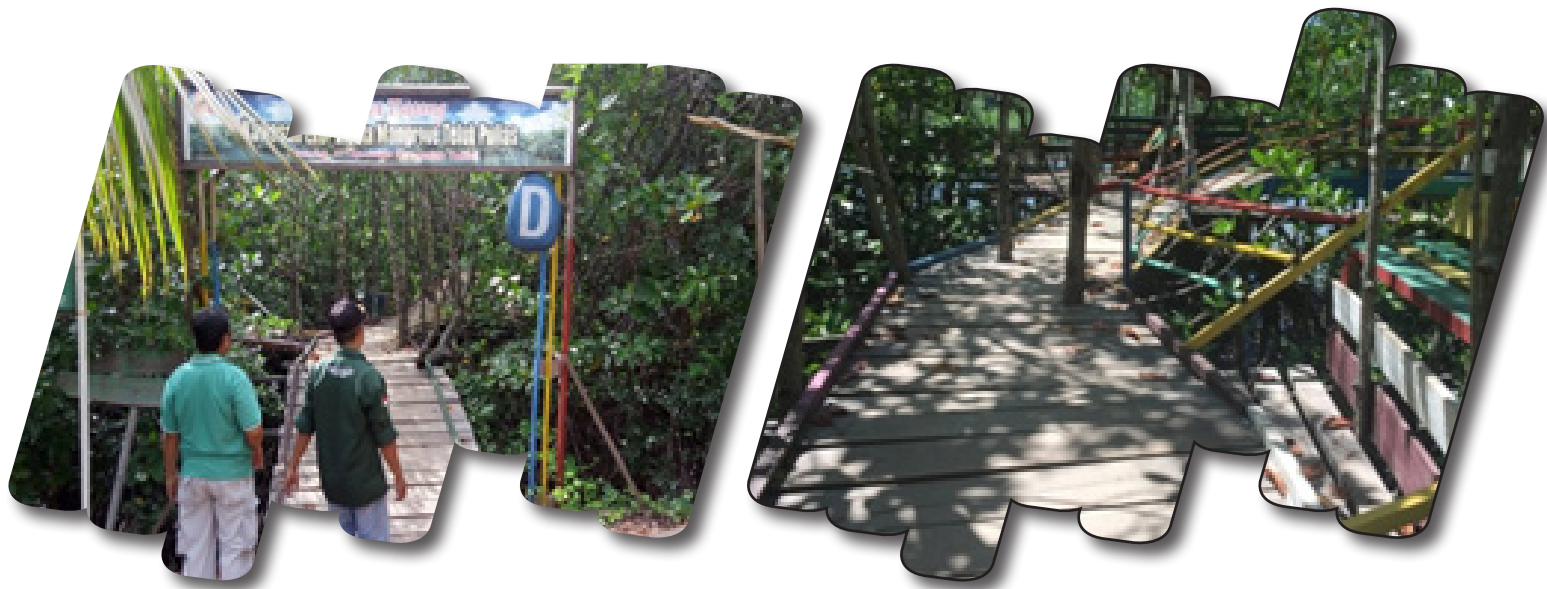
Jembatan setapak yang dibangun secara swadaya
